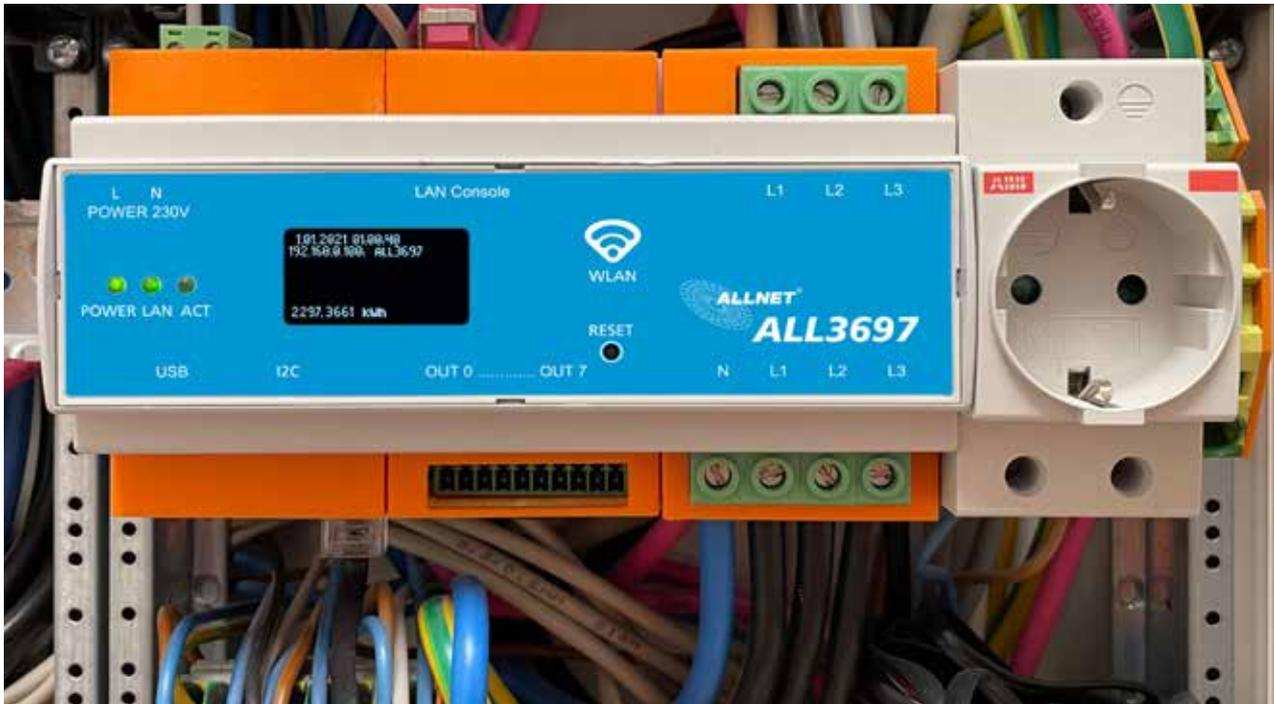
Der ALL3697 bietet die bequemste und gleichzeitig praktischste Art der Stromverbrauchsmessung. Durch die Montage auf der Standardhutschiene lassen sich die elektrischen Verbraucher schnell und sicher an die Powermeterzentrale anbinden. Zudem stellt diese Installationsart eine übersichtliche und ordentliche Verkabelung sicher. Nach erfolgter Installa-
